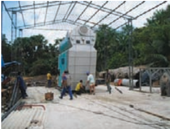
Figura 11.9 – Caldeira sendo fixada na base
