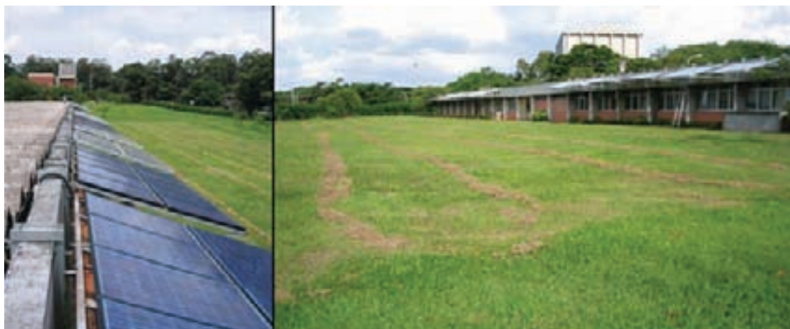
(b) Fachada fotovoltaica conectada à rede (IEE/USP)
