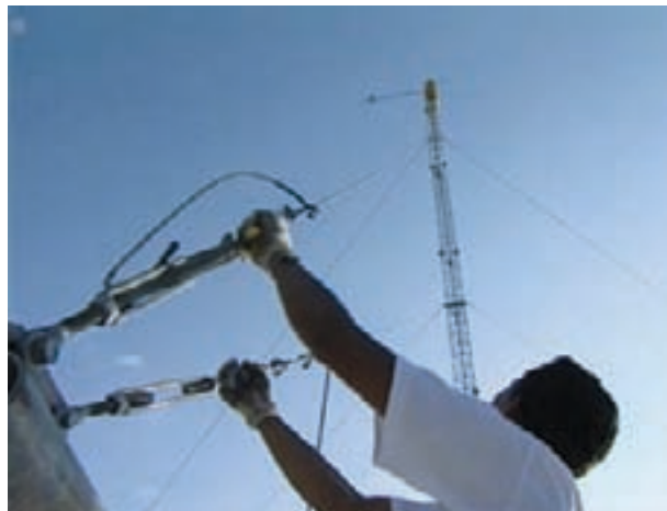
Figura 10.4 – Inspeção dos cabos e atracção da torre do aerogerador
