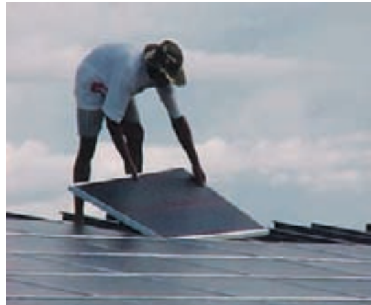
Montagem do arranjo fotovoltaico
