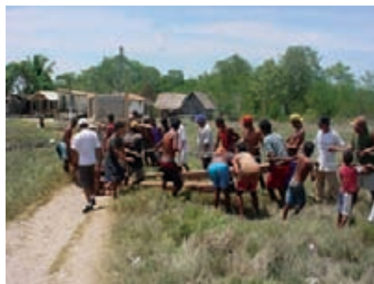
Translado do inversor/retificador até a casa de força
