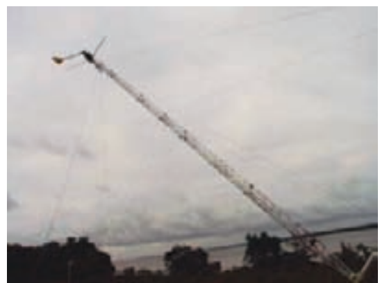
(e) Içamento do conjunto torre/aerogerador
