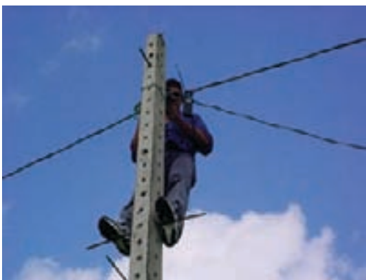
Instalação do cabeamento da minirrede de distribuição
