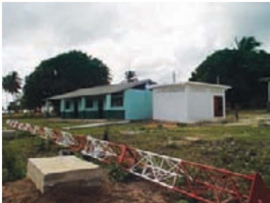
Torre do aerogerador montada no chão
