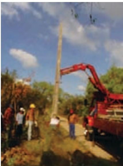
Instalação dos postes de concreto da rede de distribuição
