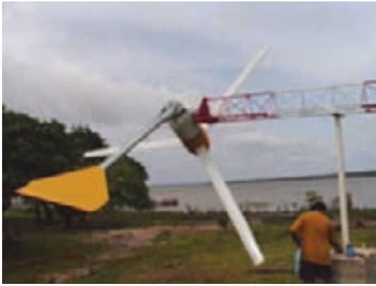
Aerogerador acoplado à torre
