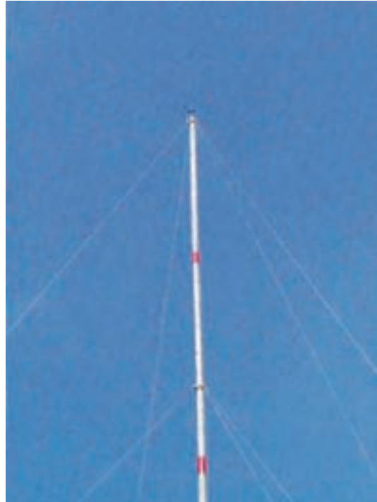
Torre estaiada da estação meteorológica
