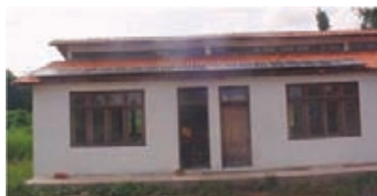
(b) Módulos fotovoltaicos instalados sobre o telhado da edificação
