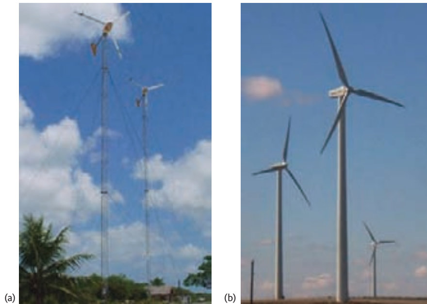
Figura 3.37 – Torres: (a) treliçadas; (b) tubulares
