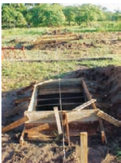
Preparação das bases de suporte da torre do aerogerador (III)
