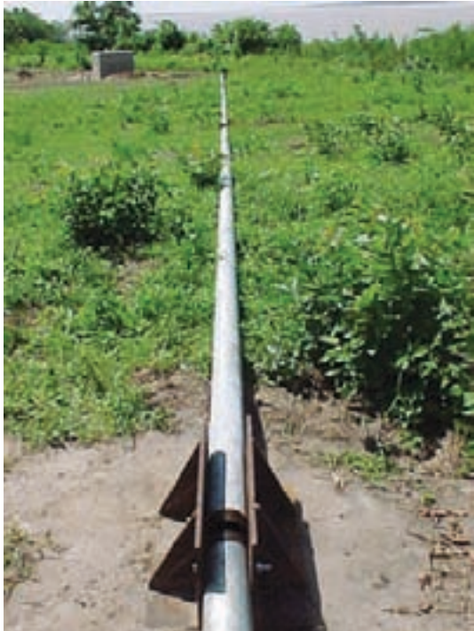
Torre da estação meteorológica montada no chão
