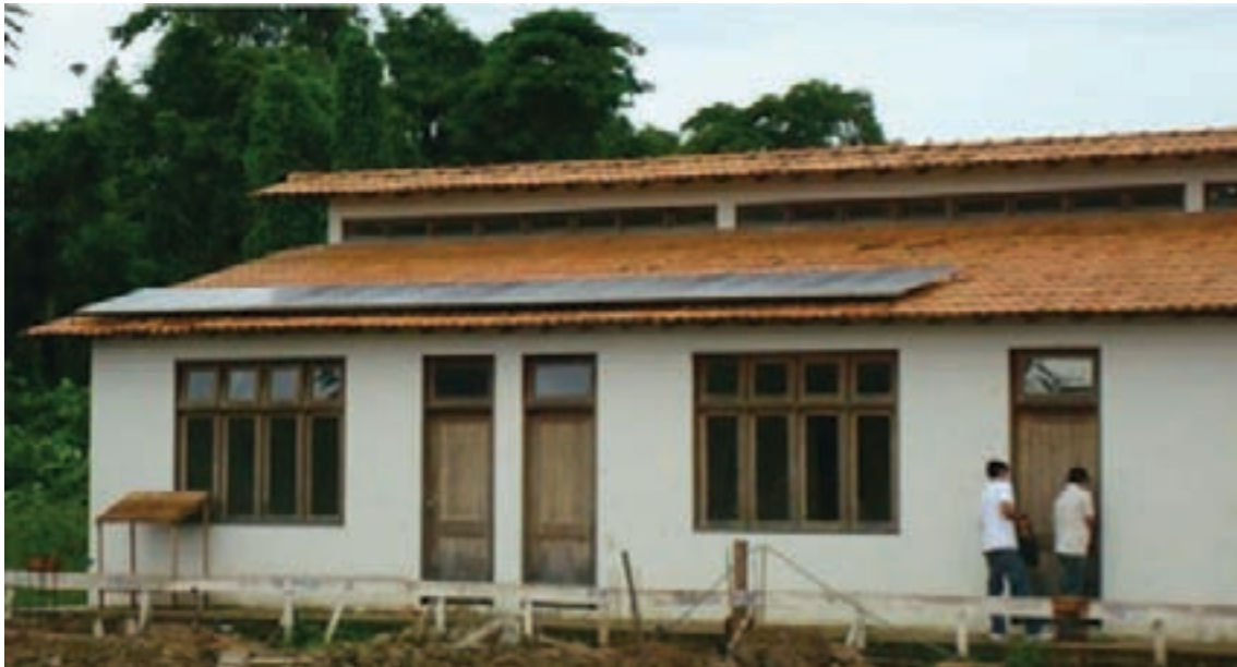
(a) Telhado fotovoltaico conectado à rede elétrica (GEDAE/UFPA)
