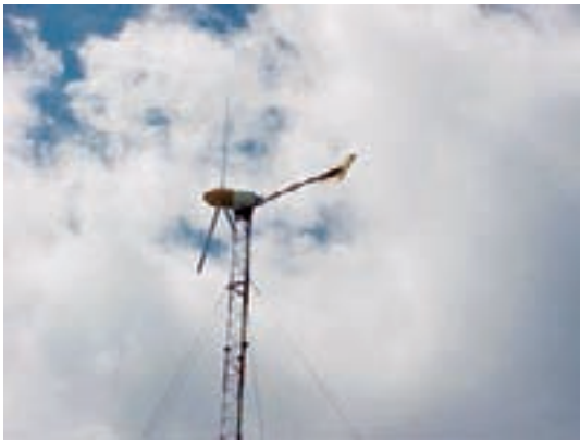
Aerogerador com o leme dobrado (retirada da direção predominante do vento)
