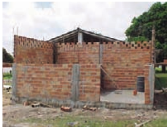
Casa de força em construção
