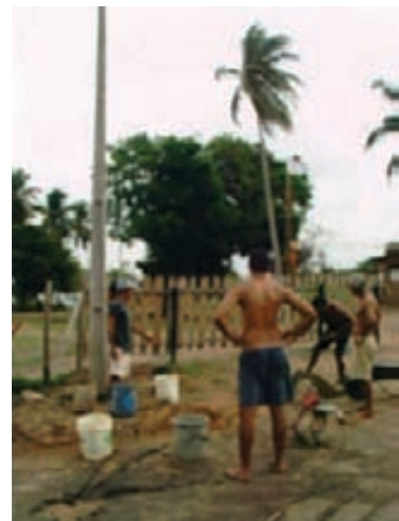
Fixação dos postes de concreto feita pelos moradores locais
