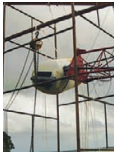
Aerogerador sendo montado no topo da torre
