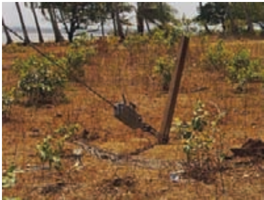
Tífor utilizado para o erguimento da estação
