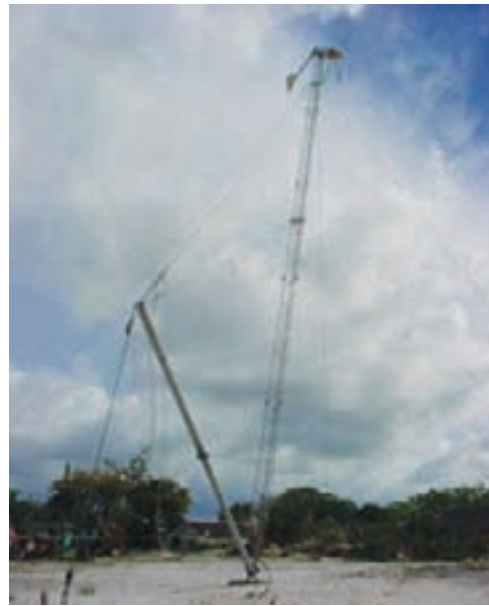
Torre de um aerogerador sendo abaixada para realização de manutenção
