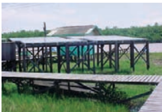
(c) Módulos fotovoltaicos instalados sobre o solo através de estrutura de madeira
