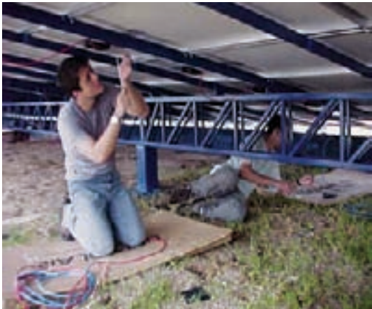
Interligação dos módulos fotovoltaicos
