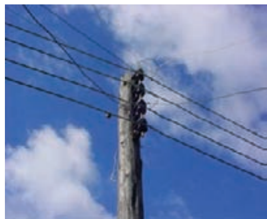
Poste madeira e fiação da rede de distribuição trifásica em péssimas condições
