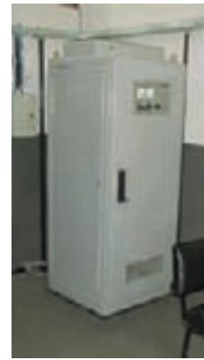
(d) Inversor 16.000 W, 120 V_{CC} -127/220 V_{CA} 3 \Phi 60 Hz (Equisul/GPL) Fonte: GEDAE, 2008
