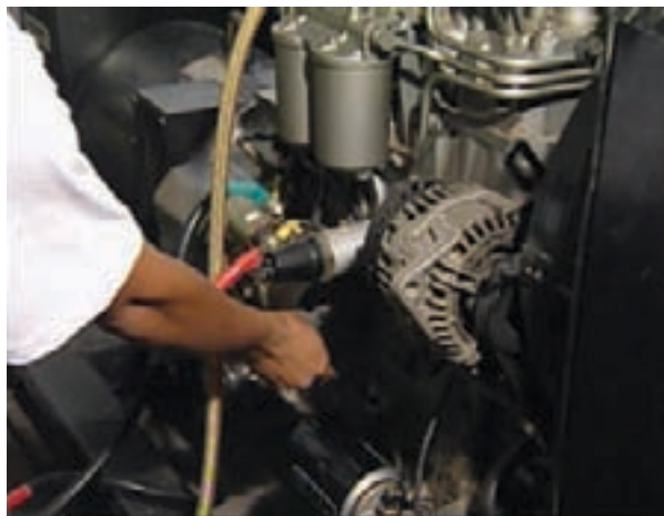
Figura 10.5 – Verificação do nível do óleo lubrificante
