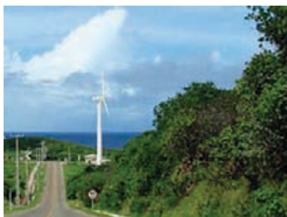
(b) Aerogerador 225 kW
