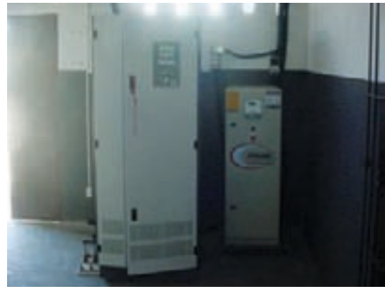
Inversor/retificador ao lado da USCA
