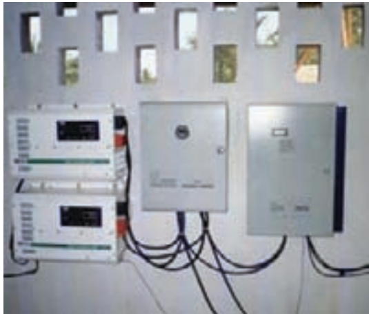
(a) Sistema de condicionamento de potência de Praia Grande
