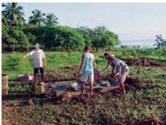
Preparação das bases de suporte da torre do aerogerador (I)
