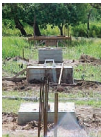
Bases da torre do aerogerador
