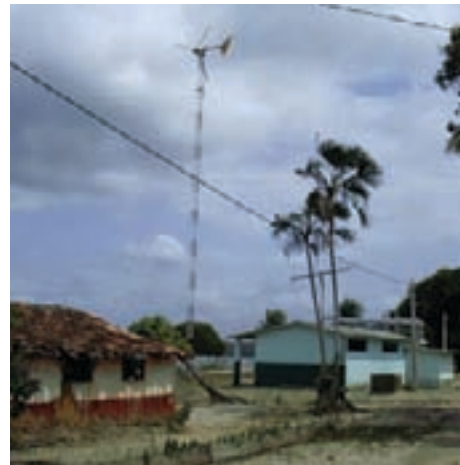
(b) Vista do aerogerador
