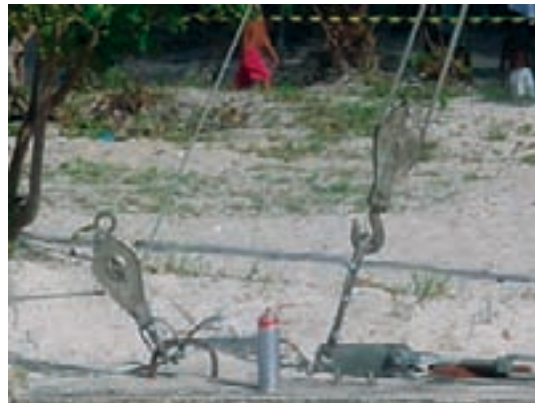
Roldanas utilizadas para redução de esforços
