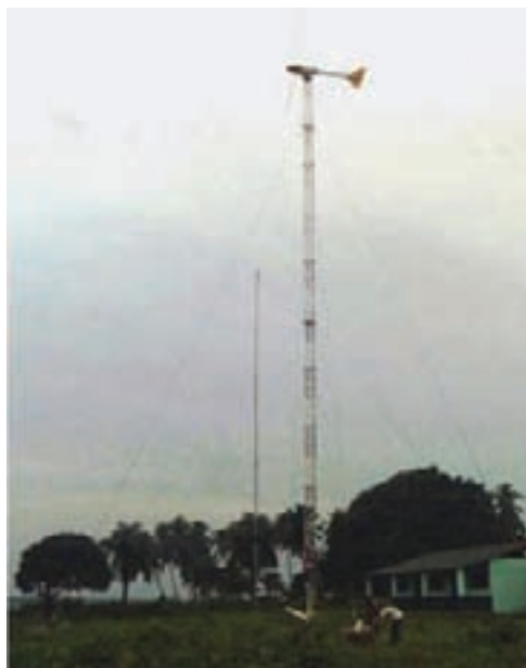
(a) Torre treliçada estaiada/aerogerador de pequeno porte
