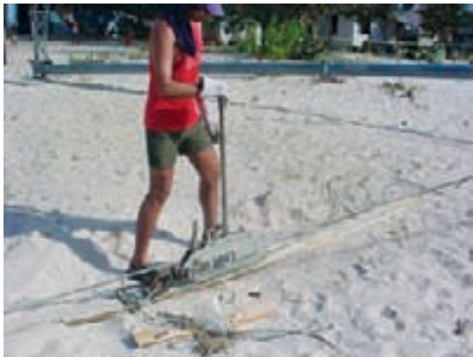
Tifor utilizado para abaixar e erguer o conjunto torre/aerogerador
