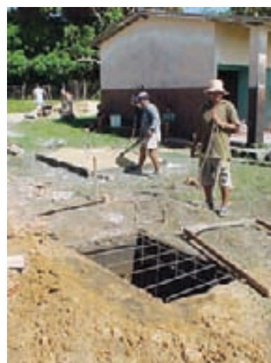
Preparação das bases de suporte da torre do aerogerador (II)
