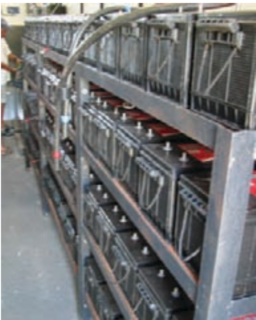
Banco de baterias sendo montado
