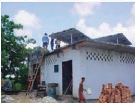
Casa de força sendo reformada (revitalização)
