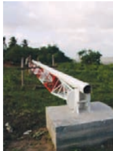
Torre do aerogerador sendo acomodada para o erguimento
