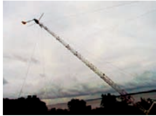
Conjunto aerogerador e torre sendo erguido
