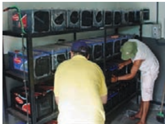
Banco de baterias novo (instalação)
