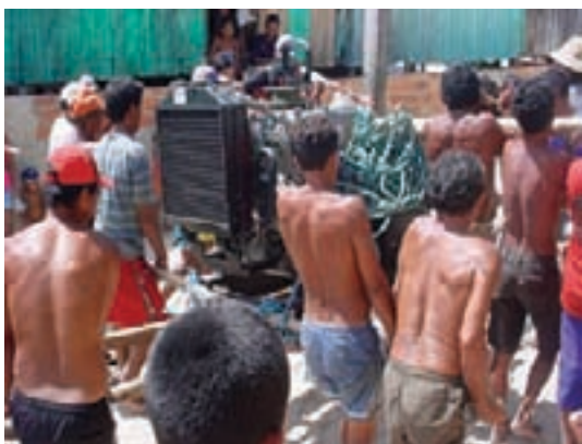
Moradores da comunidade transportando o novo grupo gerador a diesel até a casa de força
