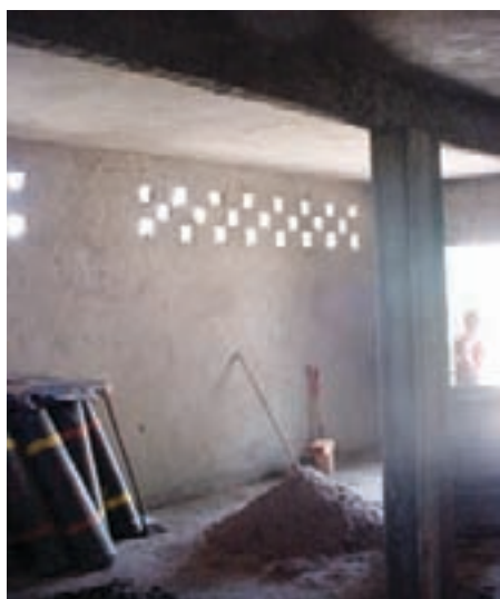
Reforma da parte interna da casa de força: (revitalização)
